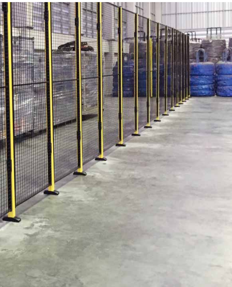
Andy Kitthanasup står framför de installerade nätväggarna.
